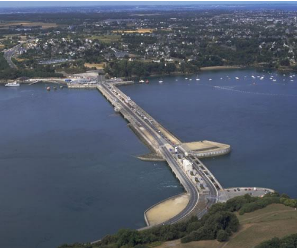
Usine marémotrice de la Rance
