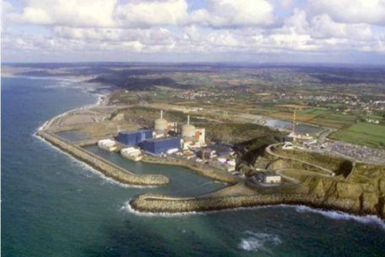
Centrale Nucléaire de Flamanville (EPR en construction)
