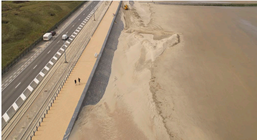
Figure 8.3: Raversijde-Mariakerke, Belgium; source: Afdeling Kust, Vlaamse Overheid
