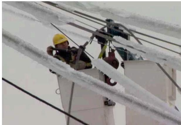
Figure 1 : Givrage sur des câbles haute-tension
